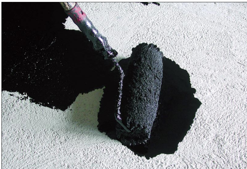
Nanos bitumenskega premaza Ibitol
