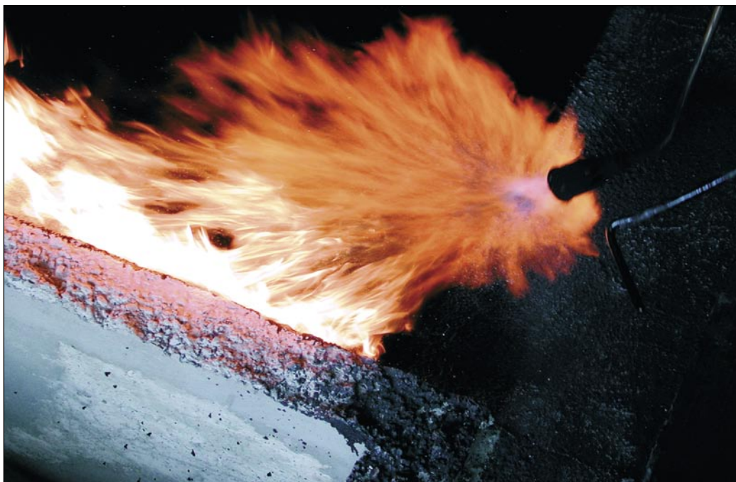
Varjenje bitumenskih trakov
