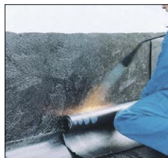
Stikovanje horizontalne z vertikalno hidroizolacijo
