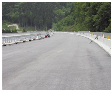
Izvedba zaščitnega asfalt betona
