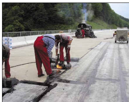
Podlivanje trakov z bitumensko zmesjo na epoksidni premaz
