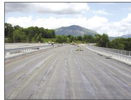
Pogled na izvedeno hidroizolacijo
