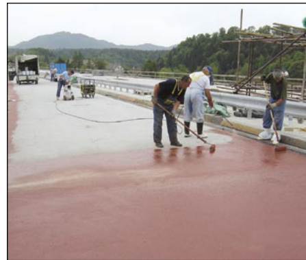
Nanašanje prvega sloja epoksidnega premaza
