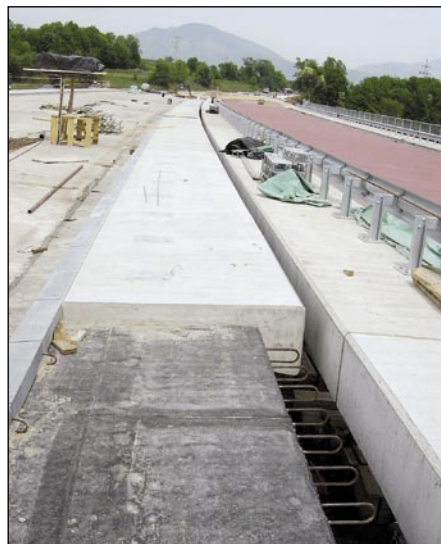
Izvedba hidroizolacije pod hodniki
