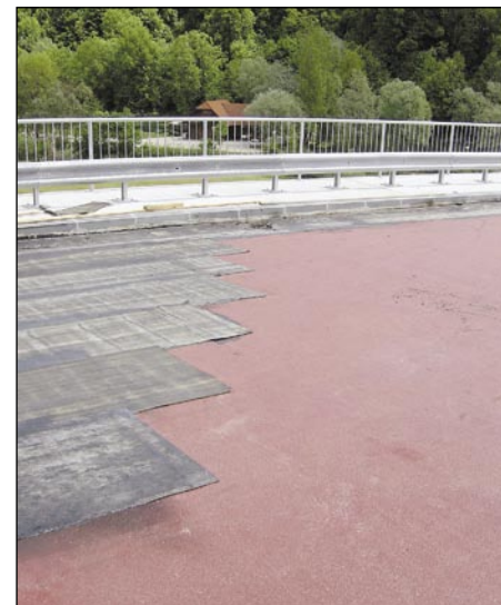
Zamik čelnih preklapov trakov
