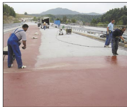
Posipavanje kremenčevega peska
