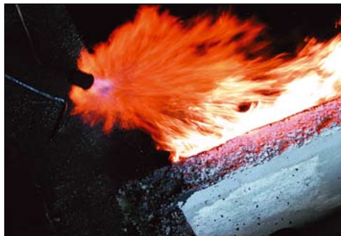
Varjenje bitumenskih trakov
