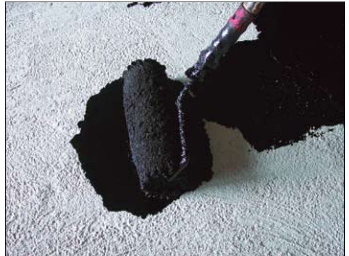
Nanos bitumenskega premaza Ibitol
