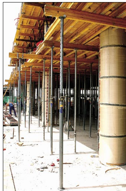
Primer uporabe opaža Reltec v poslovni večnadstropni stavbi; pod AB-ploščo je opaž že odstranjen.
