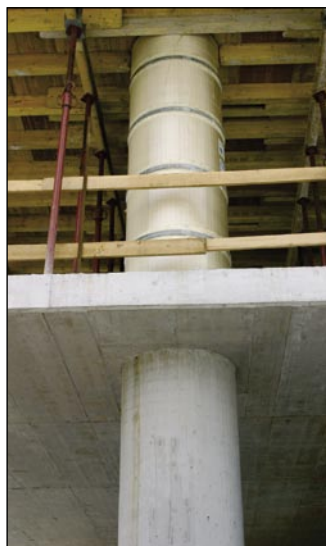
Primer uporabe opaža Reltec v poslovni večnadstropni stavbi; pod AB-ploščo je opaž že odstranjen.
