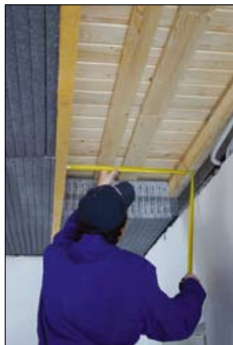
Prenašanje razmakov širin lesene konstrukcije na stisnjeno ploščo Neotekt V
