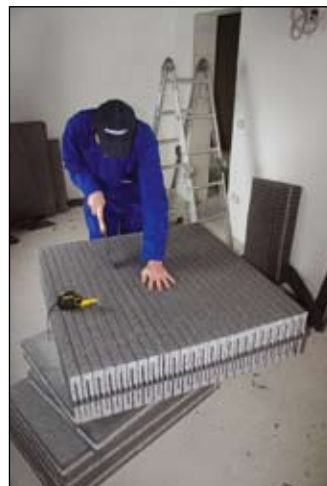
Prenašanje razmakov širin lesene konstrukcije na stisnjeno ploščo Neotekt V
