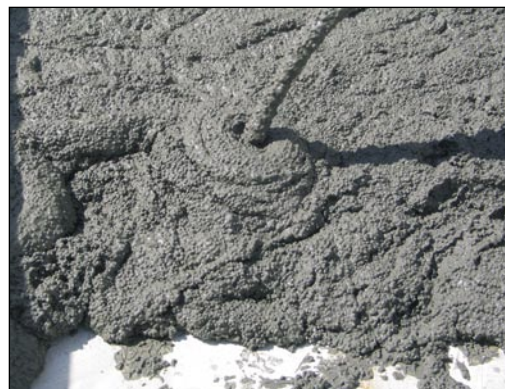
Prečrpavanje lahkega betona na mesto vgradnje
