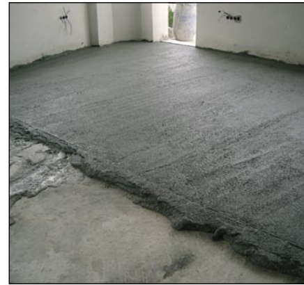
Izravnavanje lahkega toplotno izolacijskega betona Politerm
