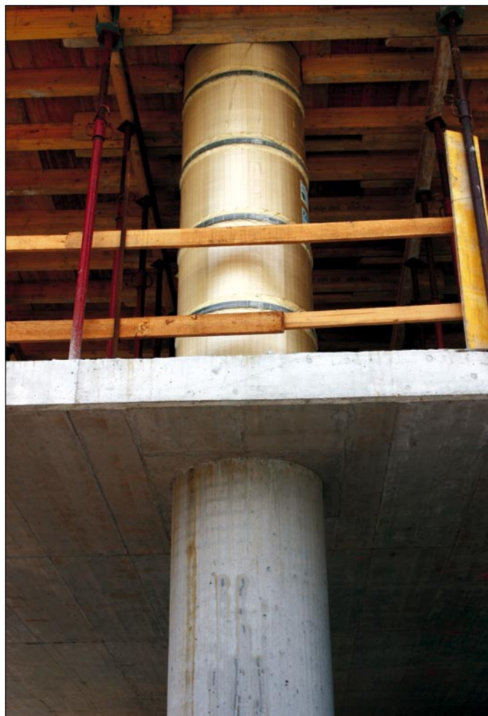
Primer uporabe Reltec opaža v poslovni večnadstropni stavbi; pod AB ploščo je opaž že odstranjen
