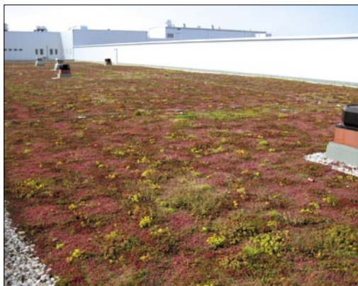
Ozelenjena streha ekstenzivne ozelenitve, površine 4000 m 2 , poslovni objekt na Letališki cesti v Ljubljani (po sistemu Fragmat - Optigrün).
