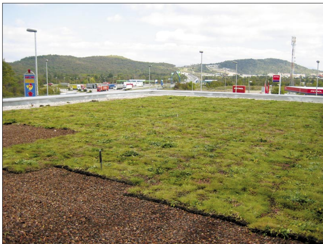
Takojšnja ozelenitev s pomočjo razvijanja vegetacijske preproge, površine 1200 m 2 , objekt pri Sežani (po sistemu Fragmat - Optigrün).
