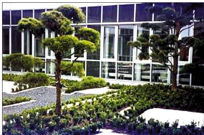
Landesbank, Poslovni objekt, Kiel-Wellsee, Nemčija, intenzivna ozelenitev, 45 cm substrata, površina 450 m 2
