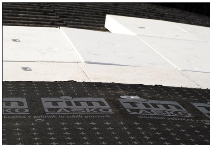
Izoself samolepilni bitumenski trak prilepljen direktno na podlago iz Stiropornih plošč.
