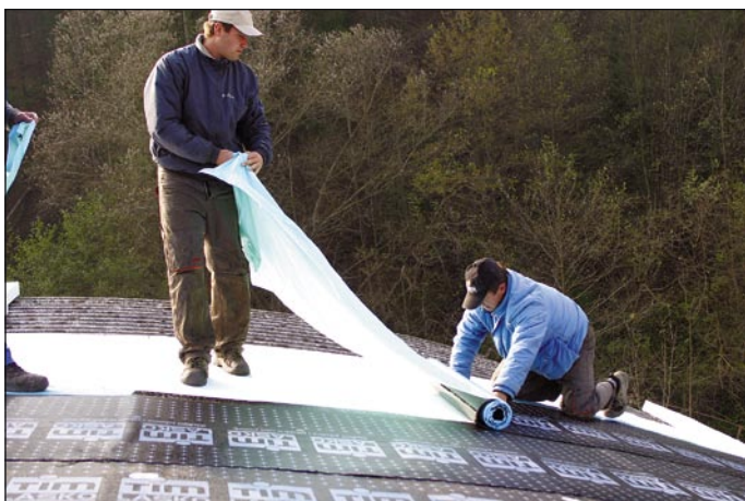
Odstranjevanje poveščene zaščitne folije s površine samolepilnega bitumenskega traku Izoself.
