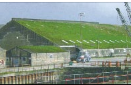
Z ekstenzivno ozelenitvijo so lahko ozelenjene celo izredno lahke konstrukcije.
