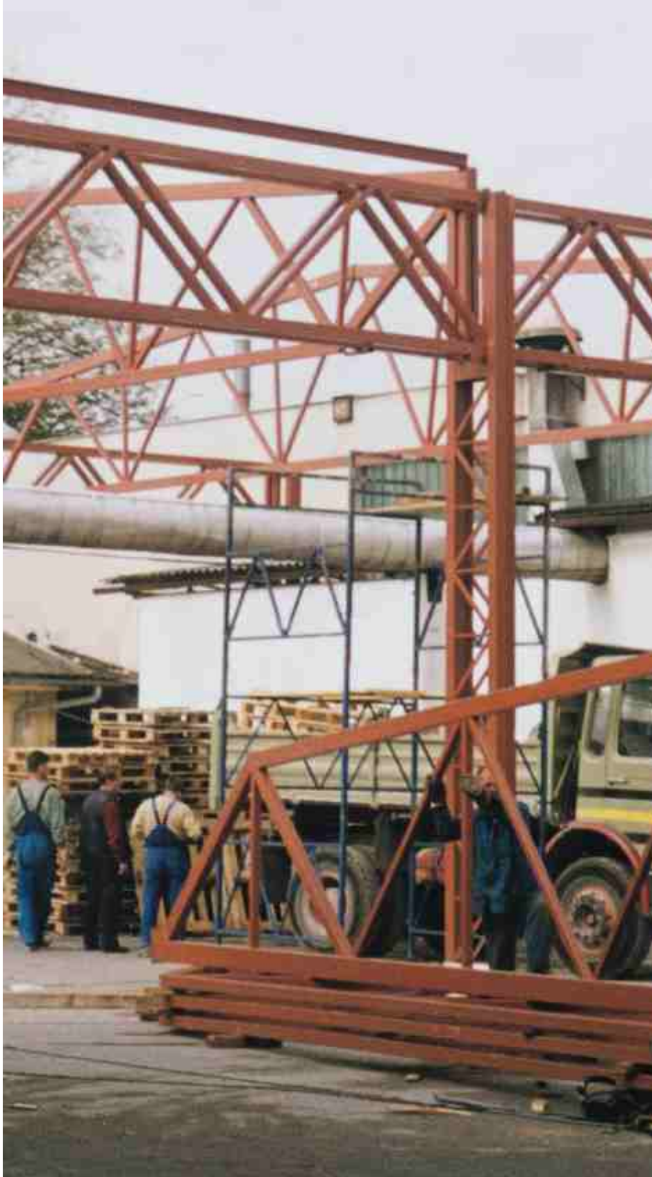
Varjene jeklene konstrukcije
