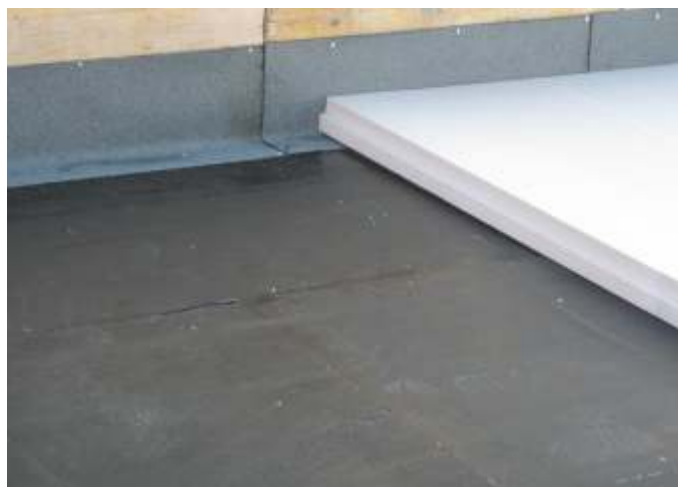
Priključek za vertikalno hidroizolacijo
