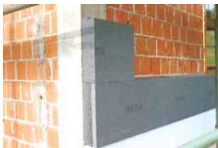
Toplotna izolacija fasade
