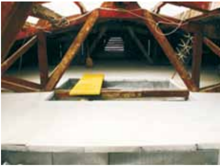
Toplotna izolacija stropa proti podstrešju
